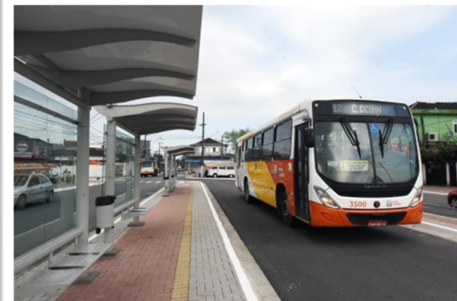
Estação de Transbordo de Passageiros, no bairro Antártica
