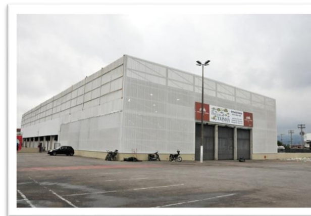
Pavilhão de Eventos Jair Rodrigues, no bairro Quietude
